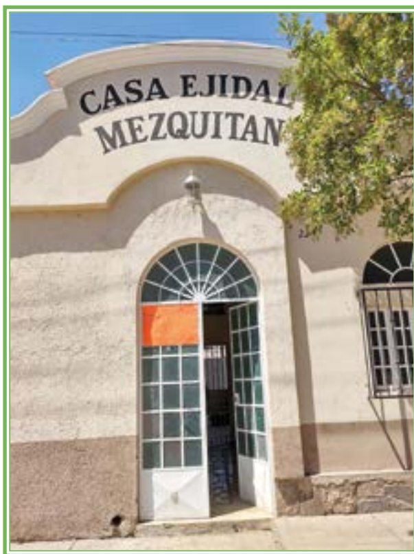
LA REMODELACIÓN permite utilizarlas como centros de capacitación.
