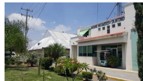
Modernas y funcionales instalaciones y capacidad de almacena de 25 mil tons de granos
